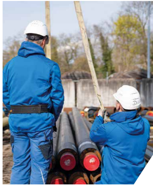
Fernwärmerohre werden für den Abtransport vorbereitet.
