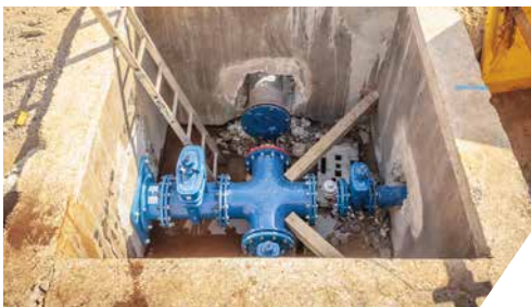
Einbindung TT-Stück im Schacht mit Absperrschieber
