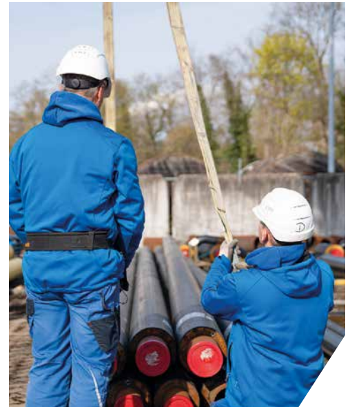
Fernwärmerohre werden für den Abtransport vorbereitet.
