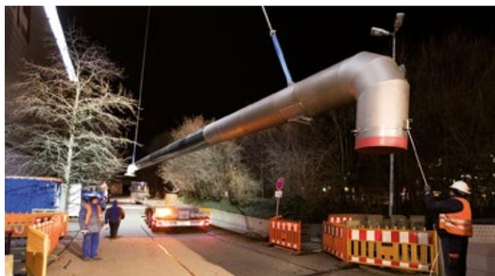
Installation der Fernwärme-Rohrbrücke über die Güterbahntrasse bei Mann Mobilia zur Versorgung von Durlach
