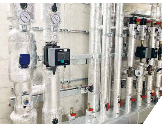
Neuer Heizungsverteiler in Bau 9
