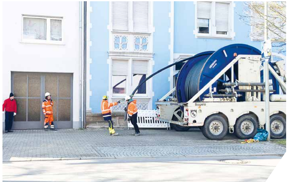
Vorbereitungen zum 110-kV-Kabelzug an der Startgrube Durmersheimer Straße
