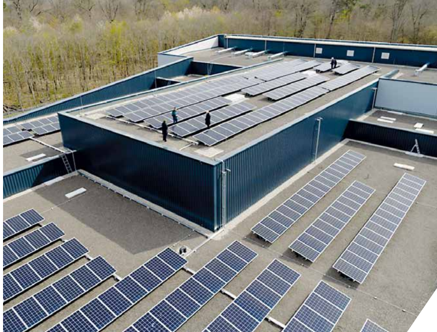
Die Photovoltaikanlage auf dem Neubau des Wasserwerks Mörscher Wald trägt direkt zur Stromversorgung der Pumpen bei.
