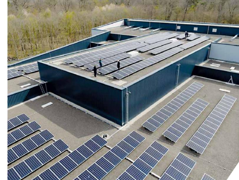
Die Photovoltaikanlage auf dem Neubau des Wasserwerks Mörscher Wald trägt direkt zur Stromversorgung der Pumpen bei.
