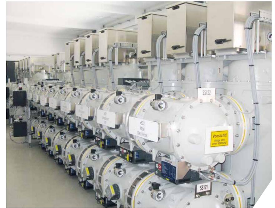
Im Umspannwerk West wurde die gasisolierte 110-kV-Schaltanlage bereits auf den Stand der Technik gebracht und dient nun als Vorbild für weitere Umspannwerke.
