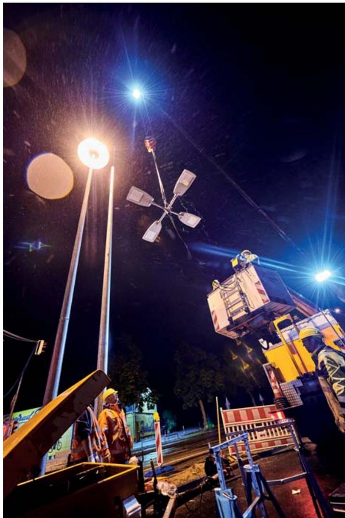
➤ Freitagnacht und es regnet: Anstatt das Wochenende zu genießen installieren die Stadtwerke-Mitarbeiter einen 14 Meter hohen Lichtmast auf einer neu gestalteten Kreuzung in Bulach. Damit ist hier sicheres Kreuzen und Queren in neuem Licht gewährleistet.
