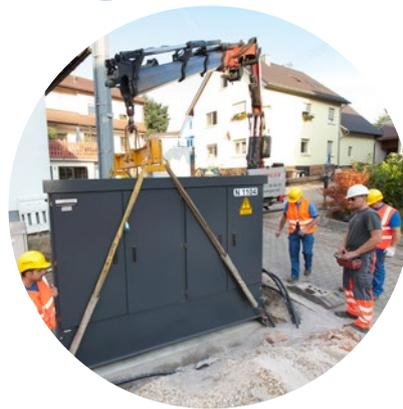
Einbau einer Netzstation in einem Wohngebiet. Hier wird die Spannung auf 400 Volt reduziert.
