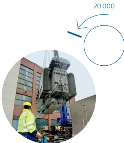
Hochspannungs-Trafos sind Kolosse, die schon mal 80 Tonnen wiegen und eine halbe Million Euro kosten. Um die Versorgungssicherheit zu erhöhen, sind sie in jedem Umspannwerk doppelt vorhanden. Fällt ein Trafo aus, stellt der andere die Versorgung sicher.
