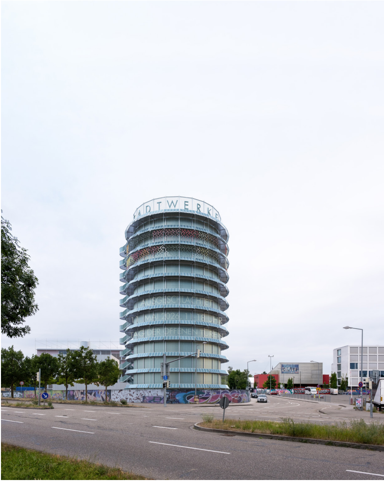
Entrée Alter Schlachthof
