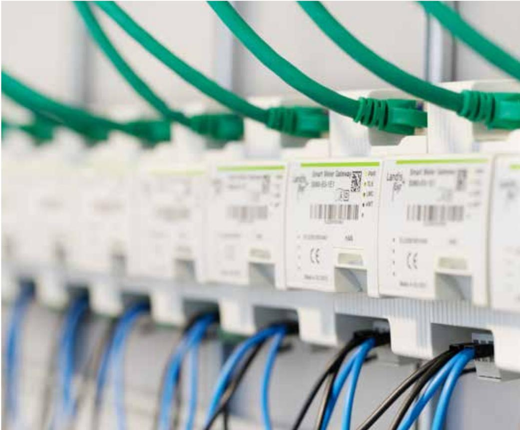
Die neuen intelligenten Messsysteme messen den Verbrauch und übertragen die Zählerstände über die sogenannten Gateways automatisch an den Messstellenbetreiber.
