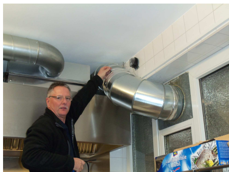
Druckabgriff in/an Haube verschließen
