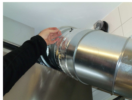
PVC Schlauch an DW abziehen
