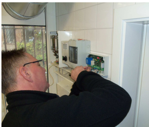
Signalleitung DW zu KCU unterbrechen
