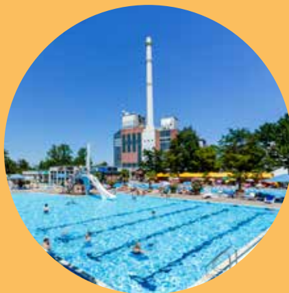
Das Sonnenbad, direkt beim HKW , wird fast ganzjährig mit Fernwärme geheizt. Es ist eines der wenigen Freibäder, die von Februar bis ersten Advent geöffnet haben.
