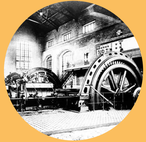
Die » Elektrische Centrale für Licht- und Kraftversorgung « hatte zu Anfang drei Dampfturbinen.
